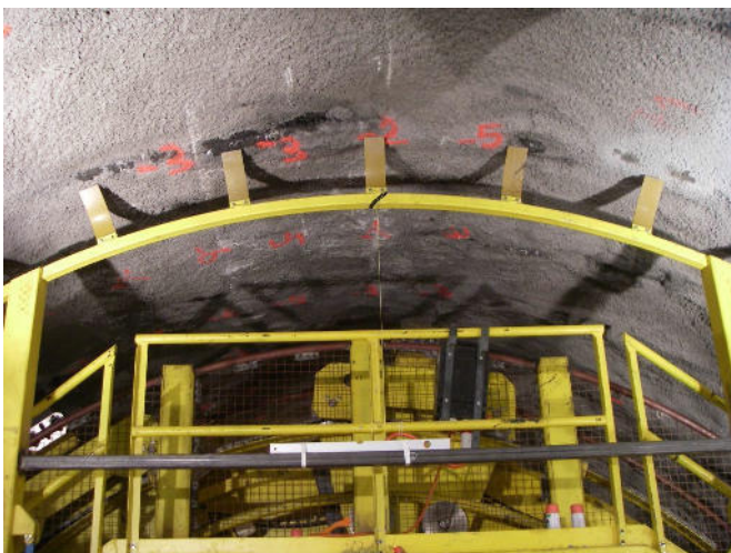
Figura 4: Verifica del profilo minimo con “carro modina” (fonte: CI GBGS/Lombardi SA)
