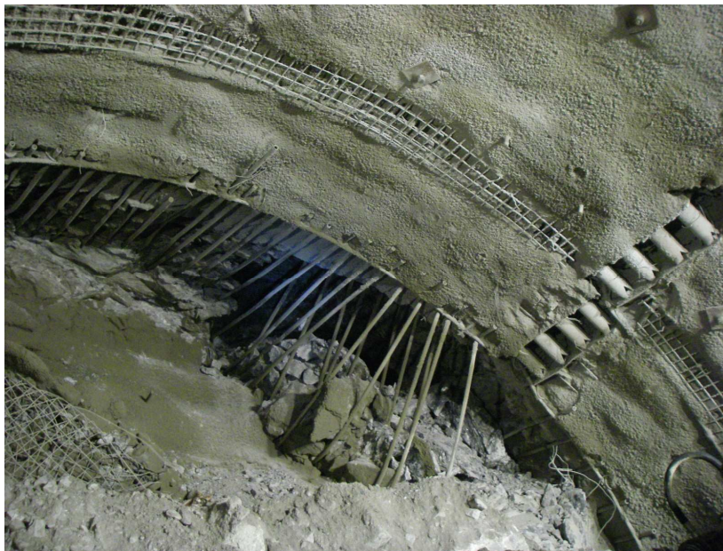
Bild 3: Ortsbrustaufnahme Station 1.231 mit Stauchelementen in der Ausbausicherung.
