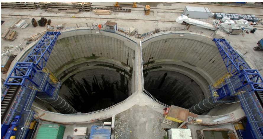
Abbildung 3: Zugang zum Untertagbereich über 2 Zwillingsschächten
