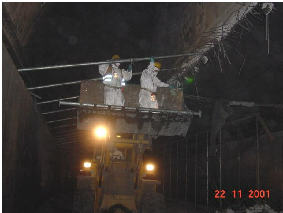
Abb. 4: Während dem Abbruch der Decke musste die Trennwand, welche im Bauwerk verblieb, sorgfältig in ihrer Lage stabilisiert werden.
