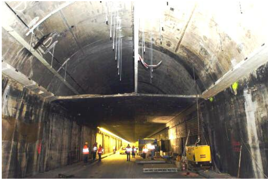
Abb. 8 (Keystone): Bauzustand vor der Montage der Deckenelemente.
