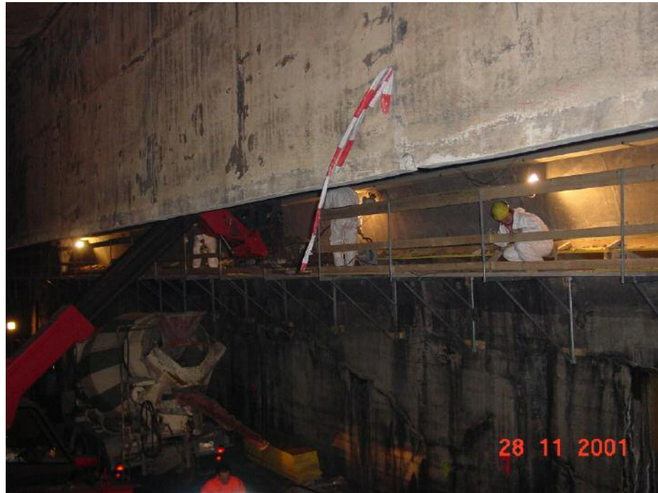
Abb. 7: Erstellung der Deckenkonsolle am Parament. Im Vordergrund ist die von den alten Decke abgetrennte Trennwand sichtbar.
