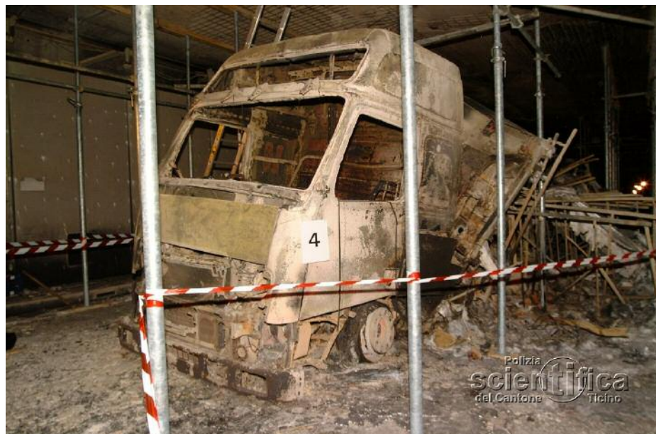
Abb. 2: Abstützung der einsturzgefährdeten Zwischendecke. Die Fahrzeugtrümmer durften nicht verändert werden.
