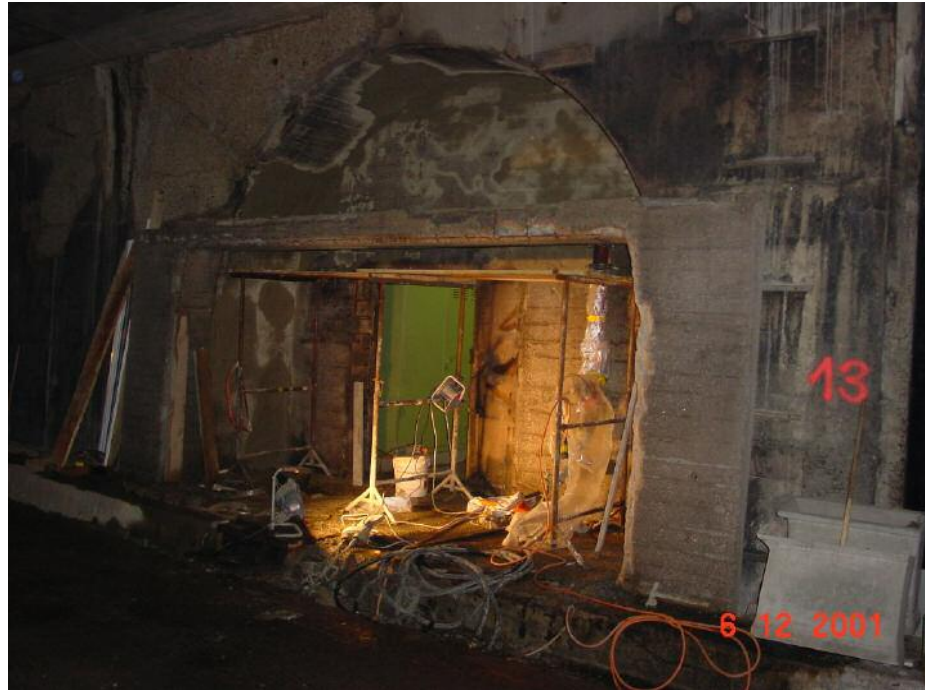
Abb. 10: Sanierungsarbeiten am Rahmen und an der Abschlusswand zum Schutzraum 69.
