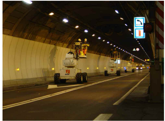
Figura 6. Operazioni di controllo della volta
